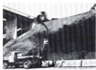
Die schwierige Hanglage nach dem Brückenbau. Der freigelegte felsige Unterboden wird mit Alginure® 100-D versetzt.
