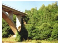
Selbst 15 Jahre später üppige Vegetation. Intensivierung der biologischen Aktivität stabilisiert Fortdauernder Bodenaufbau im Boden.
